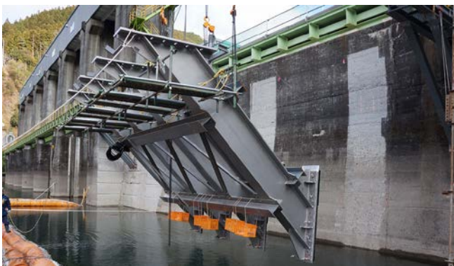
写真-4 鋼製底部架台（ブラケット部）施工状況
