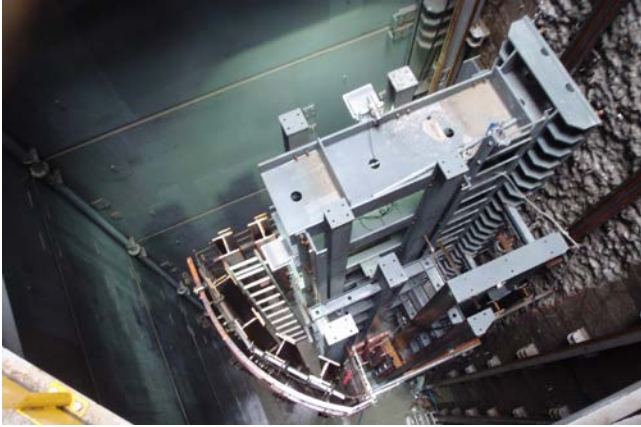
写真-7 予備ゲートピア施工状況
