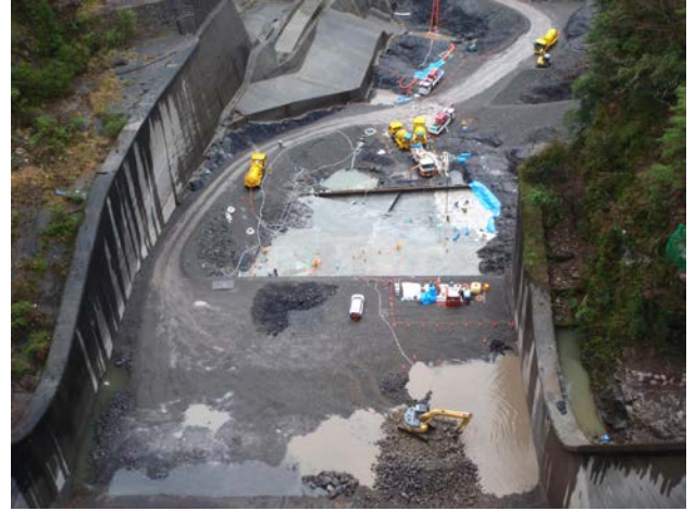
写真-9 減勢工穴埋めコンクリート打設状況
