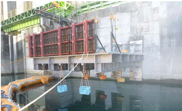
写真-3 鋼製底部架台（水平部）施工状況
