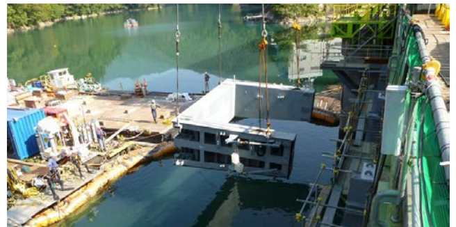
写真-5 仮締切施工状況
