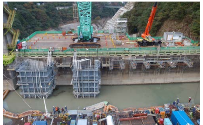
写真-6 左岸側洪水吐仮締切設置完了
