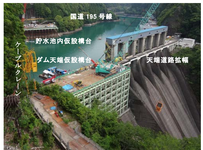
写真-2 ダム右岸から貯水池を望む
